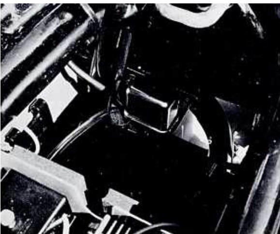
Bild 215 Eine mit BTZ ausgerüstete mit ausgebaute Batterie. Unten links der Sicherungskasten, daneben (verrippt) ein Verstärker, in der Mitte ein Relais
